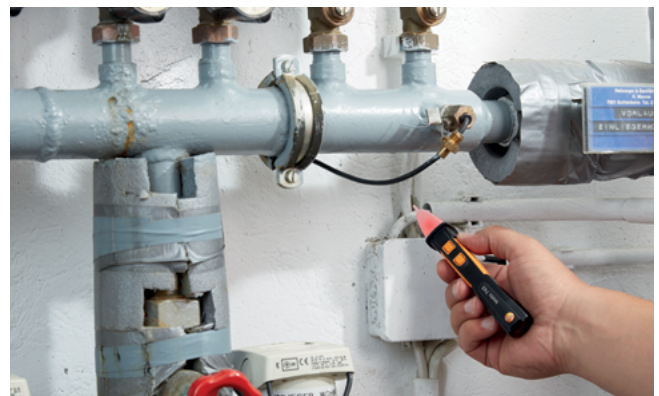
Wykrywanie napięcia w skrzynce rozdzielczej z testo 745 .
