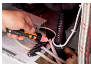
Wstępny test napięcia zasilania na sprzęzarce.
